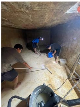
รูปที่ 2-15 ทำความสะอาดถังสำรองน้ำ
